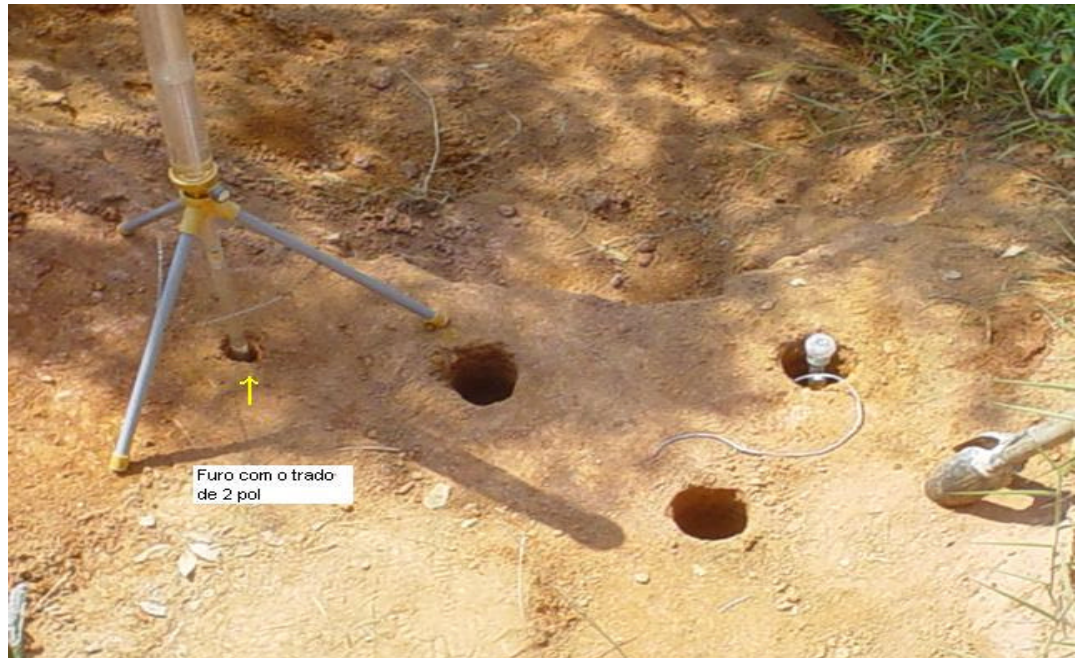
Figura 14: Ensaio com permeômetro de Guelph, para determinação de parâmetros hidráulicos no talude em Duque de Caxias.
