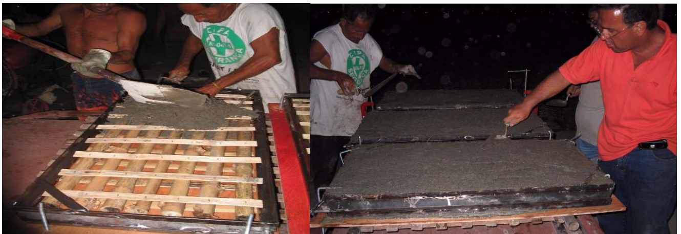
Foto 20: Painéis com bambu
