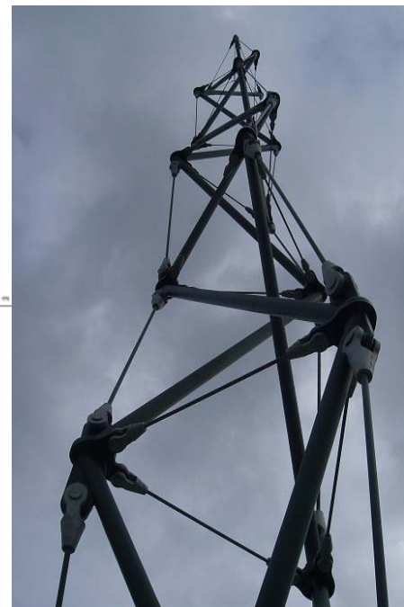
Foto 17: Torre de Rostock
