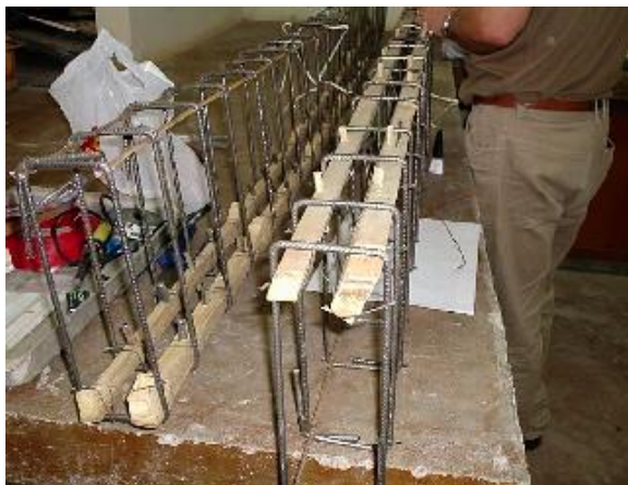
Foto 21: Reforço no concreto
