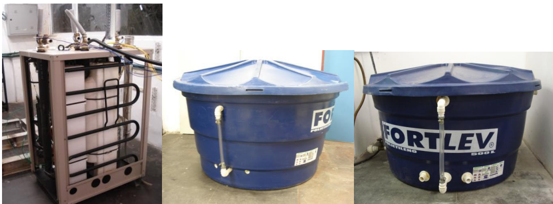
ARS. Robur, Reservatório Frio e Reservatório Quente
