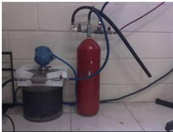
Figura 13. Detalhe do tanque de combustível.
