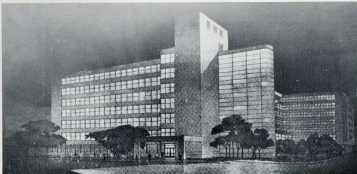
Vista do conjunto
