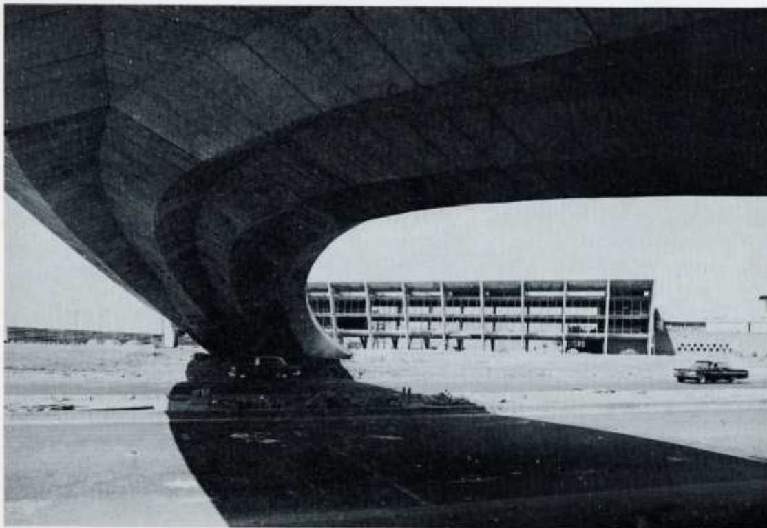
Viaduto Paulo Bittencourt Aterro da Glória-Flamengo Rio de Janeiro, RJ. arq: Affonso Eduardo Reidy eng: Sidney Santos execução: 1963
