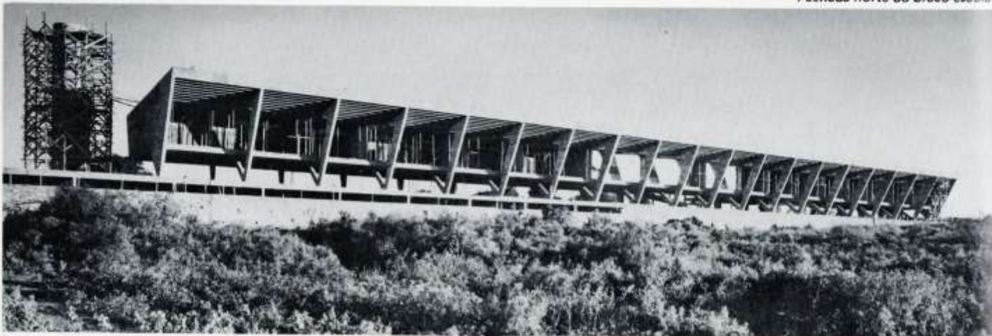
Fachada norte do bloco-escola
