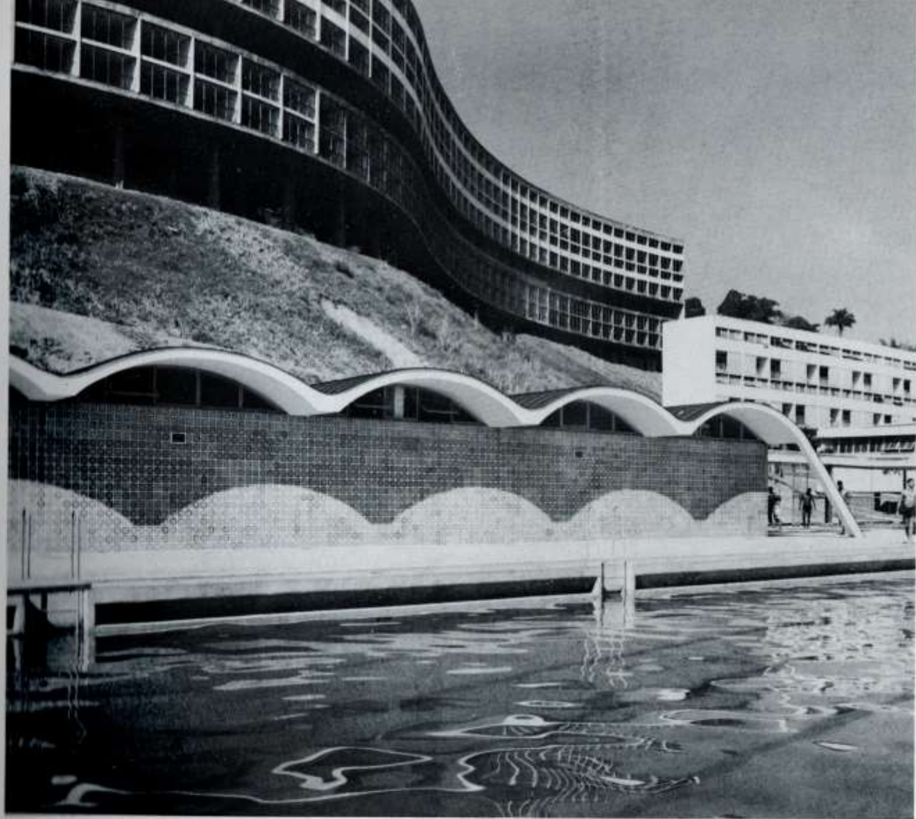
Conjunto Residencial Prefeito Mendes de Moraes Rua Capitão Félix nº 50 – São Cristóvão Rio de Janeiro, RJ. 1º prêmio na I Bienal de São Paulo arquiteto: Affonso Eduardo Reidy arquit. colab: Francisco Bolonha
